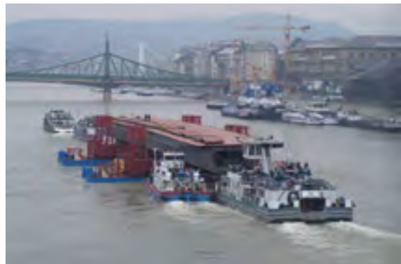
A Megyeri híd elemének víziúton történő szállítása Budapestnél
