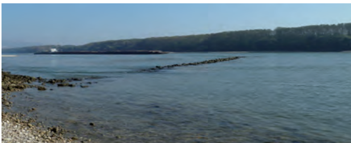
A folyó folyásirányához igazított keresztirányú mű, a folyó alacsony vízállás melletti szabályozásához
